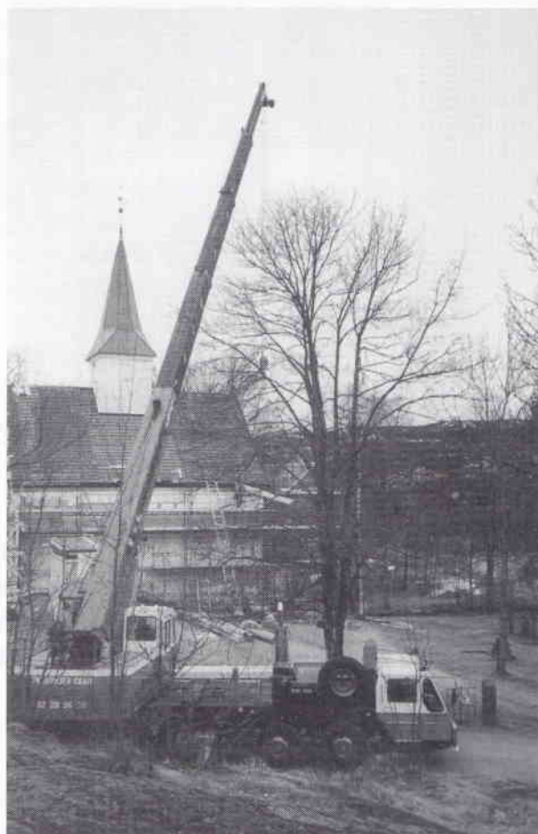
Himlingsbjelkene tres inn mellom murkrona og det «svevende tak»
