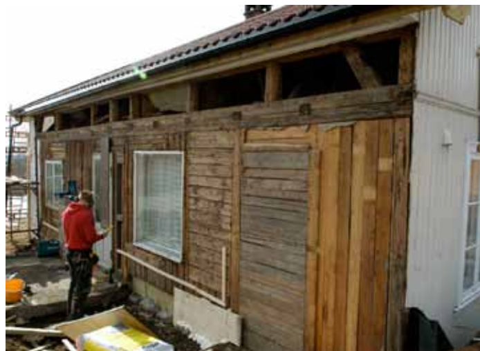
Kledningen revet under rehabiliteringen.
