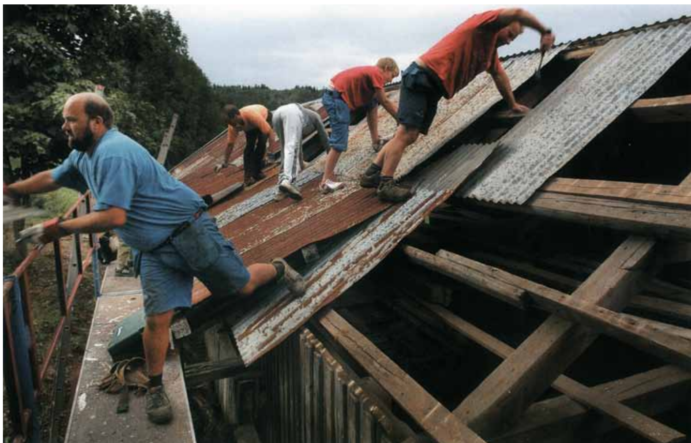
Dugnadsgjengen har tatt fatt på riving av taket mot vest.
