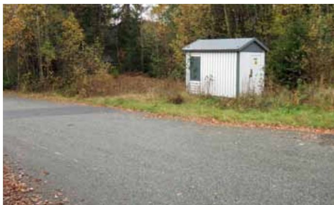
Bak trafokiosken i krysset Dalenveien/Eikholtveien lå fabrikkbygningen.
