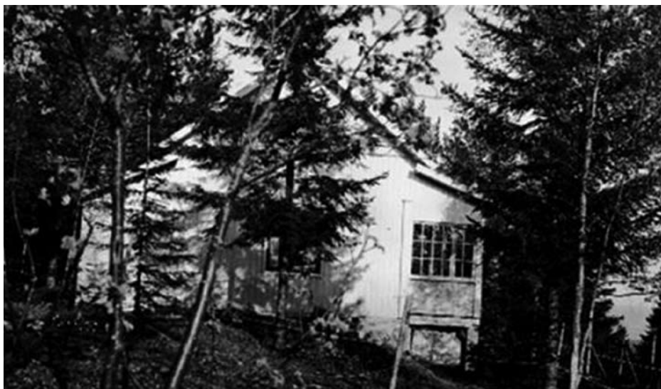
Vestre gavlveggen på barnehjemmet foran hellingen ned mot Langmyrdammen.
