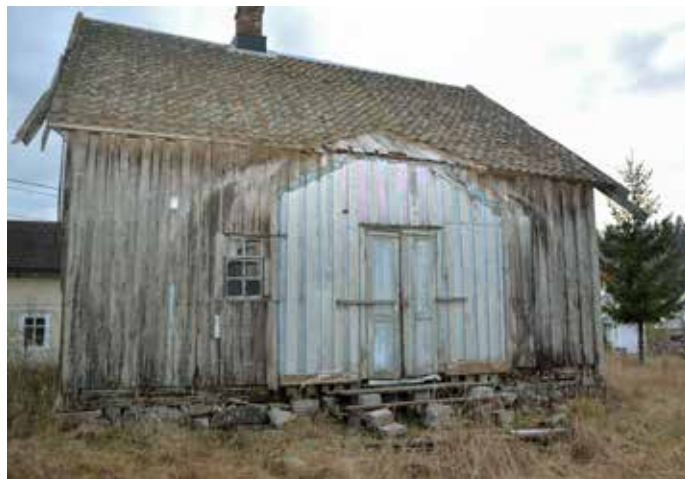
Vindfanger er revet. Foto: Tone Sverreson Ørmen.
