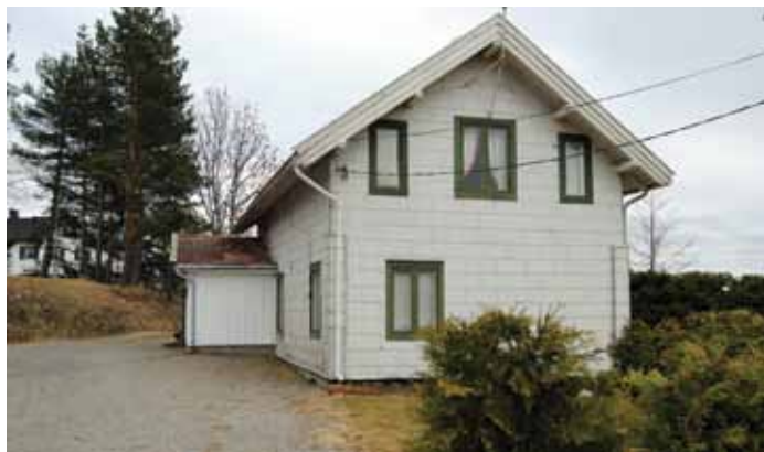
Vi ser laftehjørnene er kasset inn med eternitt på utsiden..
