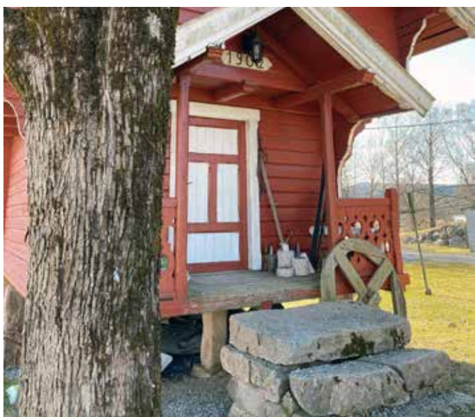
Viktigste bygget på gården, er kulturhistorisk og trenger å bli tatt vare på.
