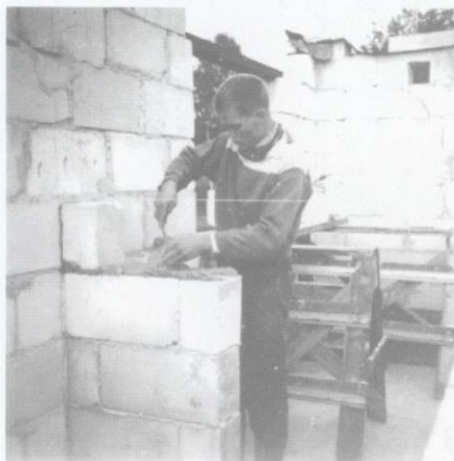
Klubbhuset ble bygget opp stein etter stein. Steinar Ruud med mureskjea sommeren 1958.
