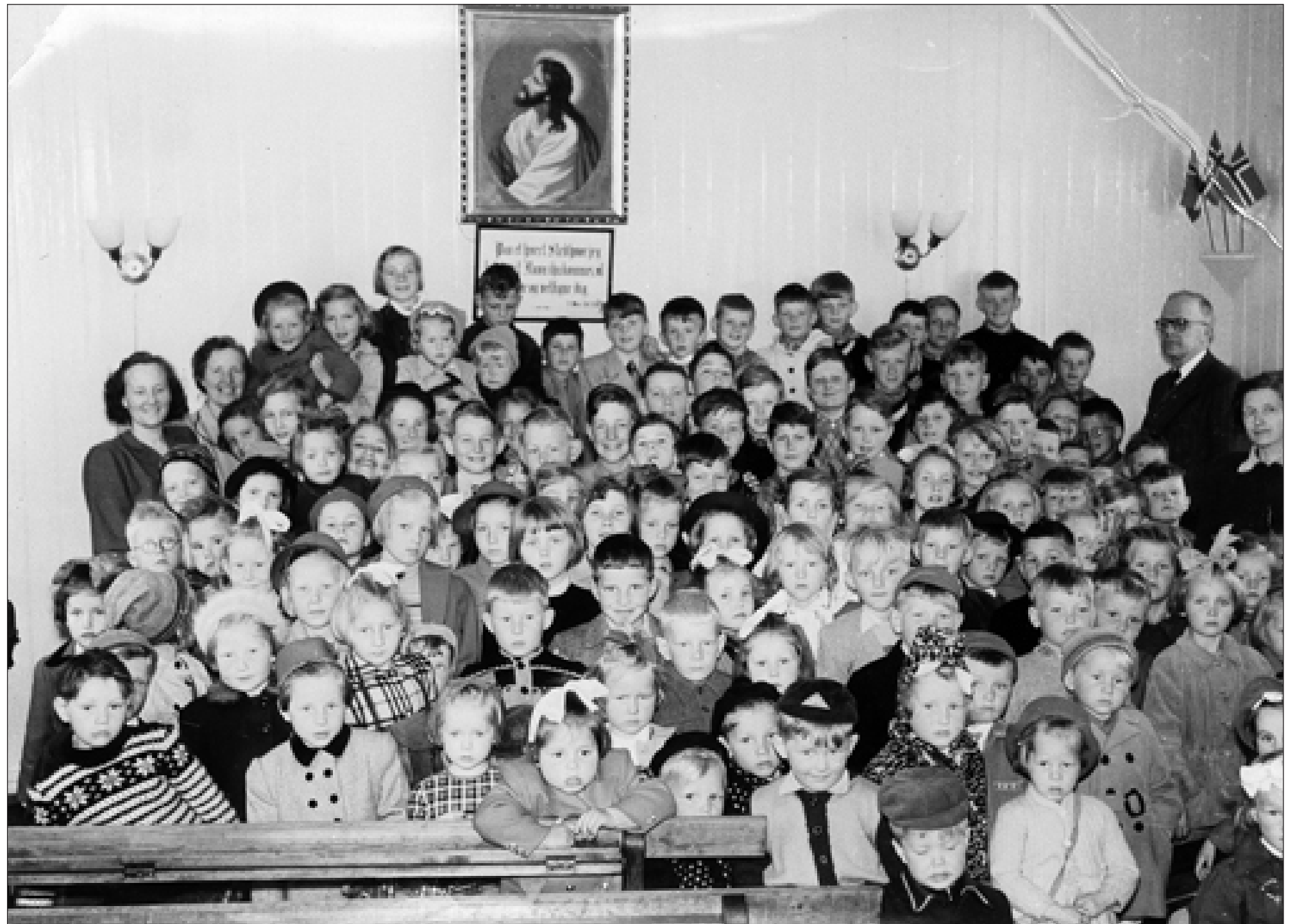
Som man ser – det var en stor flokk som samlet seg til søndagsskole i Konnerud Bedehus for 50 år siden. (Foto: Reidar Halden)
