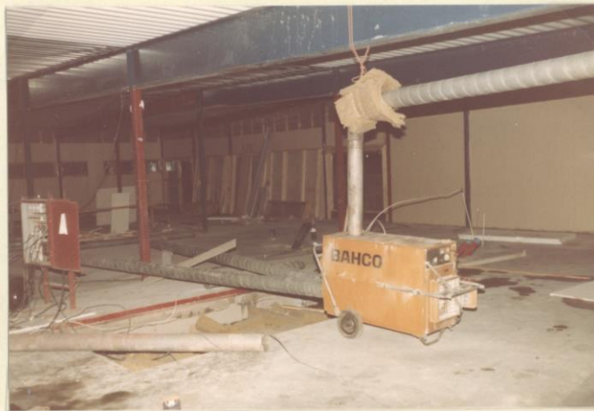
1.12.83 Når kuldegrader er ute, trengs det mye varme for å holde hallen i byggetiden varm.
