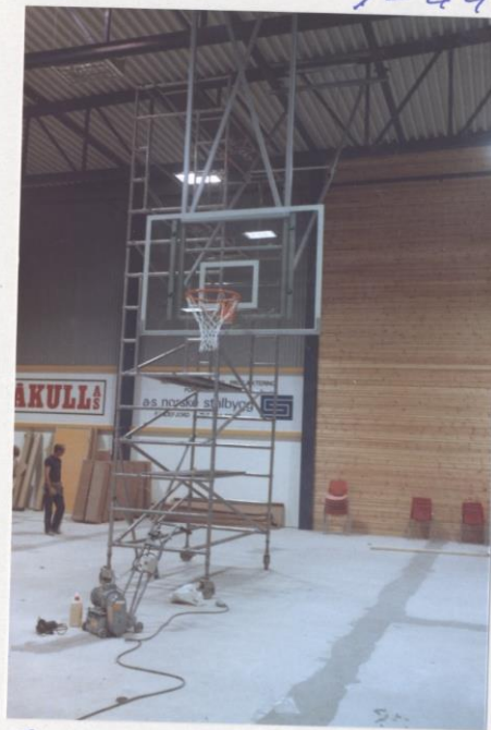
5.10.84 Det freses på gulvet fremdeles og lites etterpå
