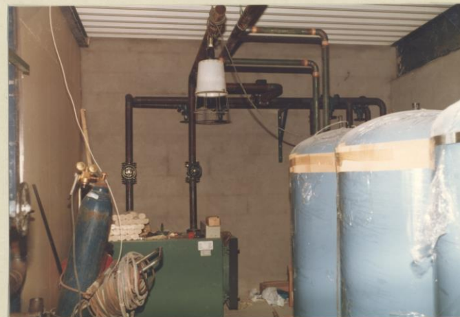
11.2.84 Kjelen i fyrrommet er kommet inn, monteringen pågår.
