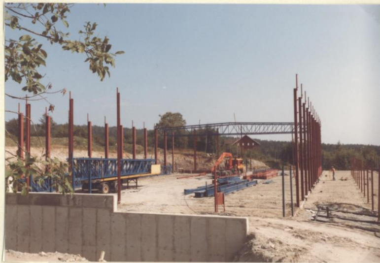
9.8.83 De første 2 takbjelker er satt på plass
