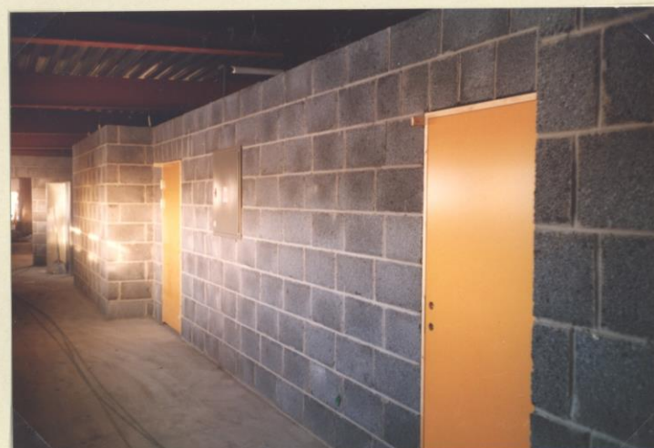
13.1.84 De første dørene i sidebygningen er kommet på plass.
