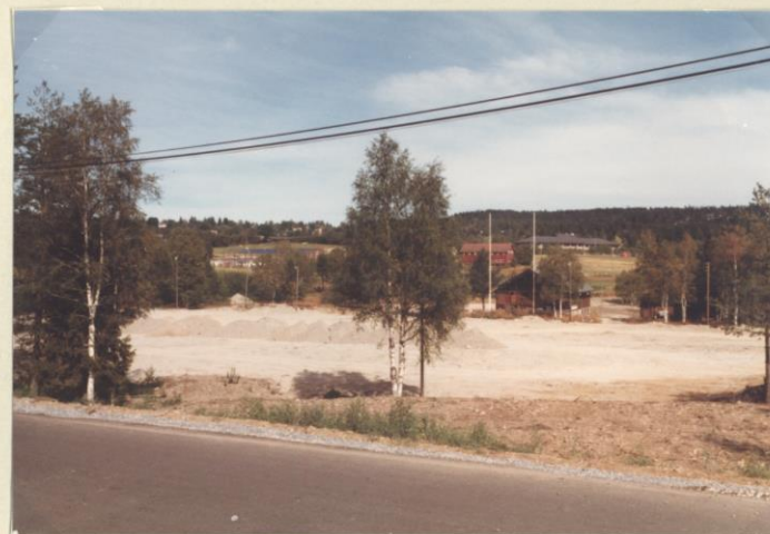
26.8.83 Fra veien ved skiundergangen begynner å se hallkonstruksjonen.
