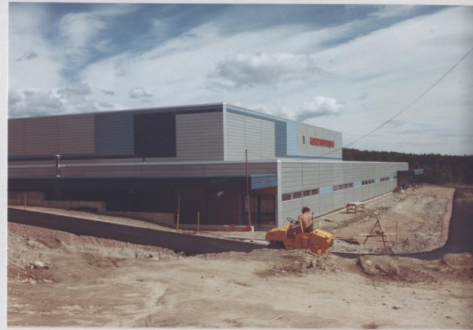
22.6.84 Gangveien ble asfaltet.
