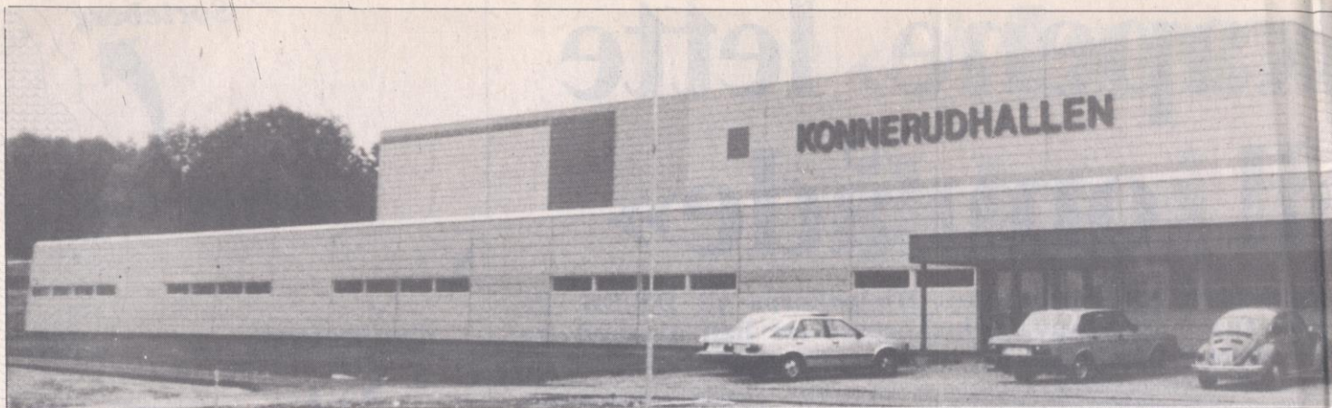
Konnerudhallen vil trolig komme på omkring 11 millioner kroner. Byggeregnskapet er ennå ikke ferdig revidert og medlemmer begynner å føle uro for lagets økonomi. — Ingen grunn til engstelse, sier formannen Geirr Kihle.
