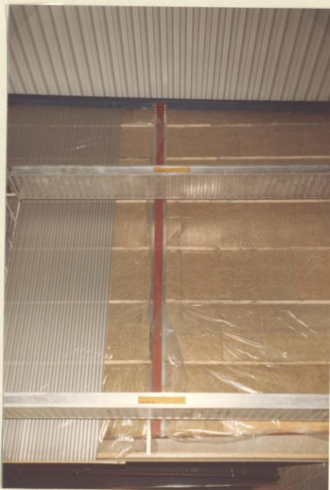
31.12.83 Veggene isoleres og dekkes med bølgeplater
