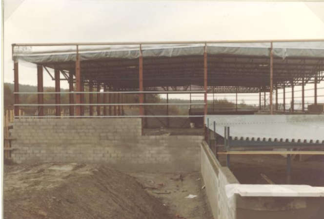
4. 10. 83 utvendig arbeides på takene og bak hallen mures, innvendig begynner gulvstøpingen.
