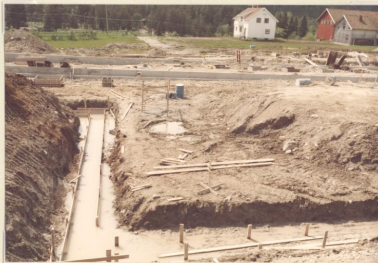
9.6.83. Det graves i den ene enden og den andre enden har forskalingsarbeidet begynt. Merkelig, hvor mye vann det er.
