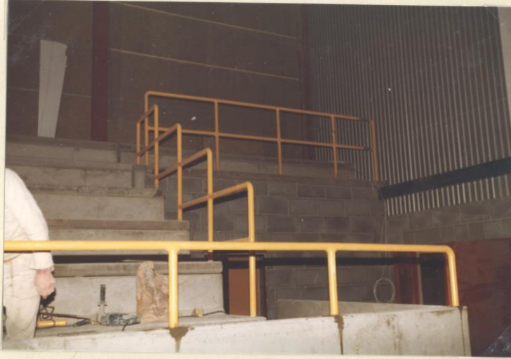
17. 2. 84. Det begynnes å sette rekkverk foran sittetribunene
