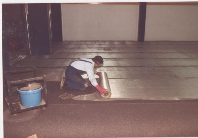
22.1.85 Opp på gumminatter legges nylonduk
