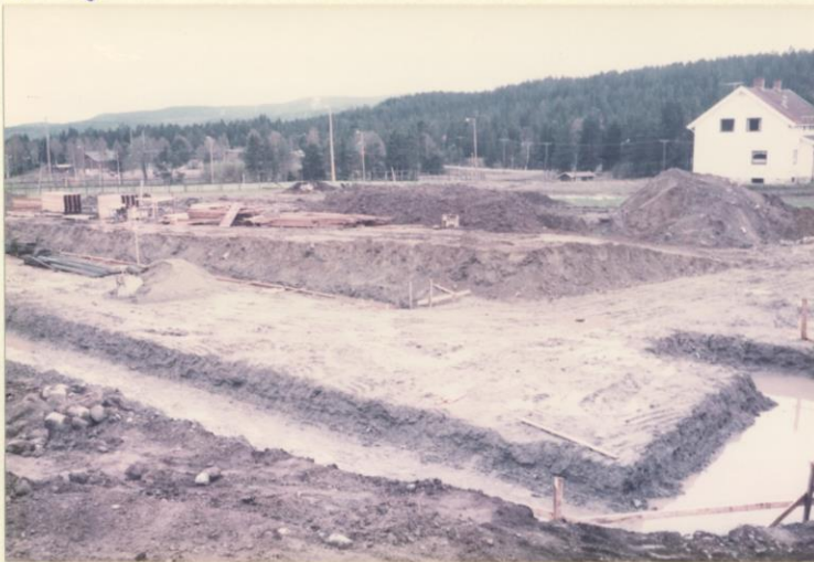
12.5.83 Regn og atter regn. Til tross av vannet går arbeidet videre. Forskaling av sålen er begynt.
