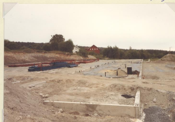
27.7.83 Rørleggere er ferdig med sin „underjordisk“ arbeid, bare rørstussene står over bakken.
