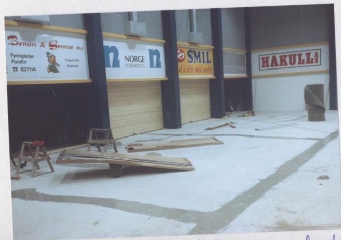
28.9.84 Arbeidet med kittingen er ferdig og det settes opp vippeporter
