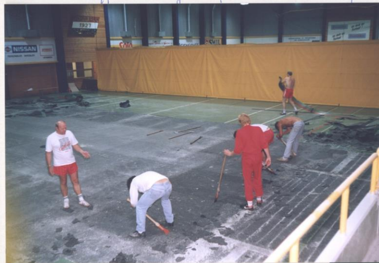
12. 8. 91 enda større areal av gulvet må rives. Det var fuktighet (vann) i svampegummilaget.
