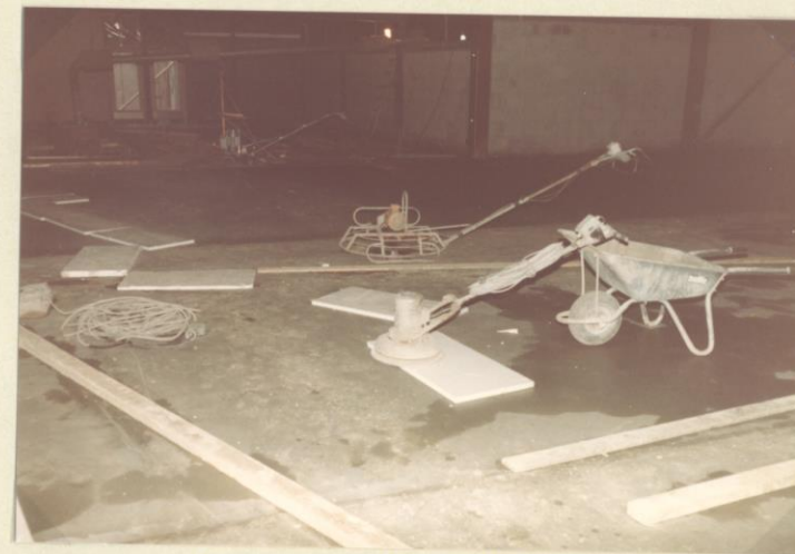
11.11.83 Har begynt med gulvstøpingen
