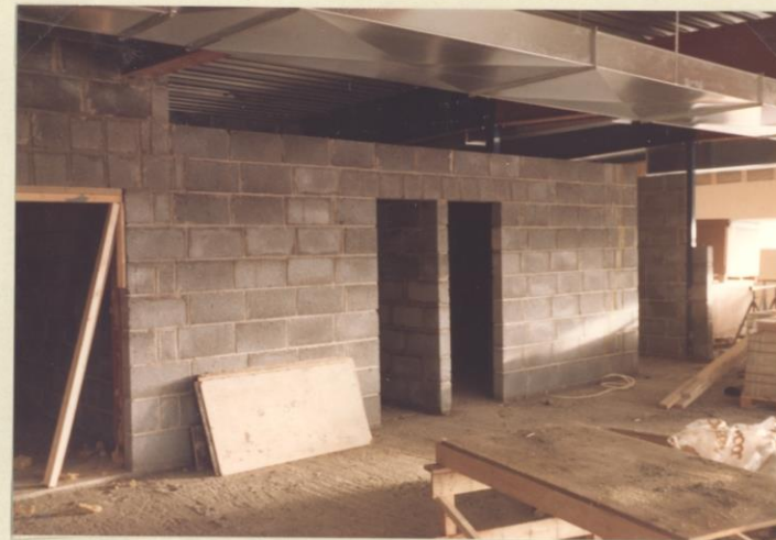
18. 11. 83 Innvendig mures det til smårum, vaskerom, avkleddingsrom og varme-ventilasjonsrørene er kommet på plass.
