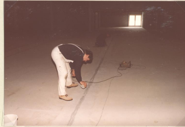
24. 2. 84 Tyskere lapper sprekker i gulvet for å få gulvet tett.
