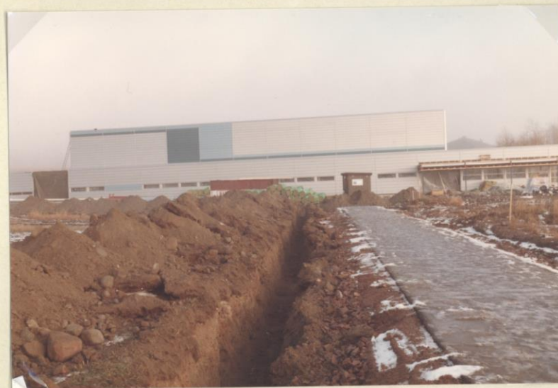
26.11.83 Ennå graves det for rørledninger.
