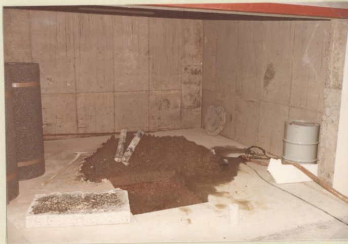
2.3.84 Det ble skåret huller i gulvet 2.3.84 for å få vannet bort og pumpe lenser vannet ut av døra.
