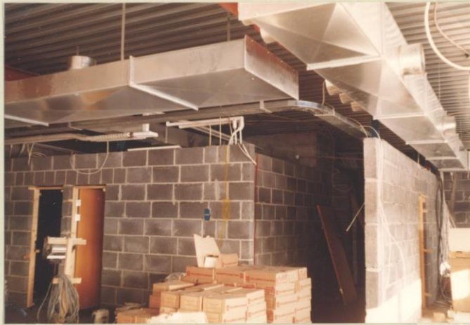
4.2.84 Se hvor mye arbeid er for- tørleggere, elektrikere og lufttrør- montasje under tak.
