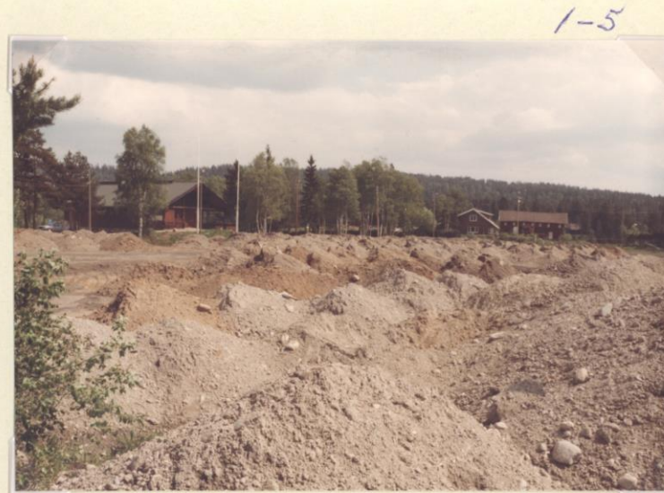
9.6.83 Kvabben fra halltomta ble kjørt til fotballbane og dermed løftes banen med ca. 1 m. for å siden drenere banen ordentlig.
