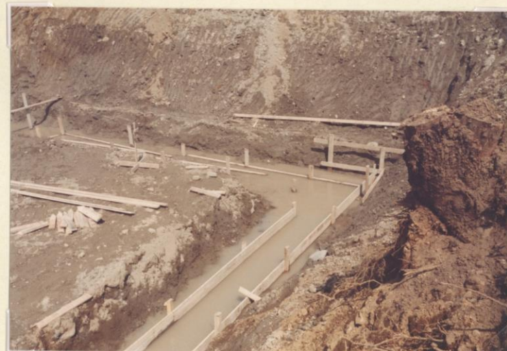
9.6.83. Det graves i den ene enden og den andre enden har forskalingsarbeidet begynt. Merkelig, hvor mye vann det er.
