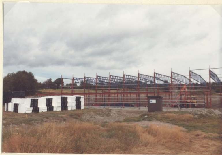
16.8.83 Alle takbjelker er på plass og en del takisolasjon ligger foran bygningen
