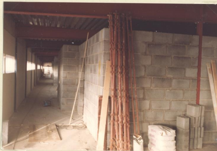
18. 11. 83 Innvendig mures det til smårum, vaskerom, avkleddingsrom og varme-ventilasjonsrørene er kommet på plass.
