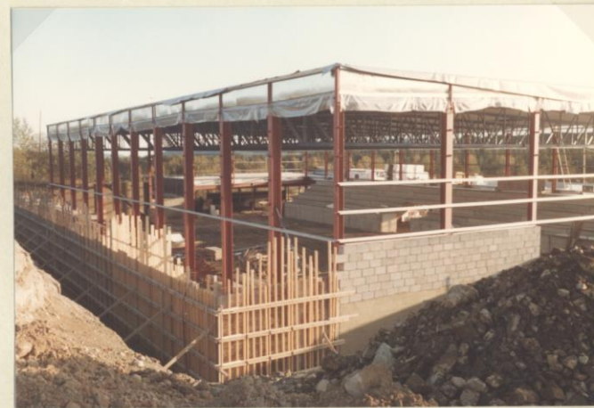
29.9.83 Det viser seg at bak hallen skal støpes ekstra plass til forskjellig materiellagre. Det er kommet utenom først oppsatte plan
