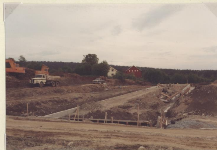
8.6.83 Med utgraving av halltomta arbeides det til sent om kvelden
