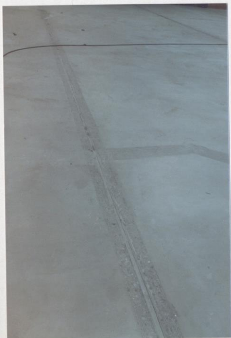
22.9.84. Det slipes igjen fuger for nytt patentkitting
