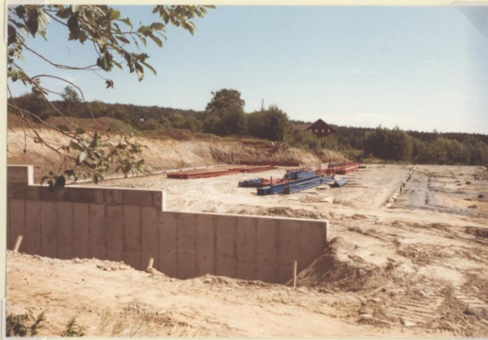
22.7.83 De første stålpeilkene for hallkonstruksjon er ankommet
