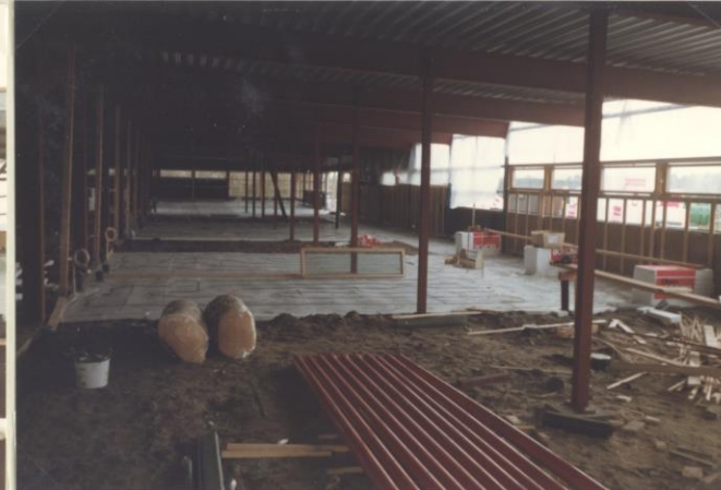
4. 10. 83 utvendig arbeides på takene og bak hallen mures, innvendig begynner gulvstøpingen.
