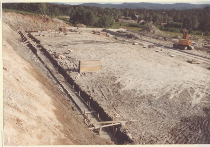
22.6.83 Fundamentstøpingen skrider fram
