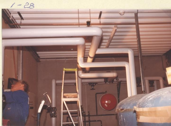
9.3.84 Rørisoleringen pågår i kjelerommet
