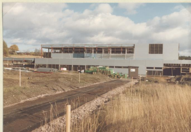
4. 10. 83 utvendig arbeides på takene og bak hallen mures, innvendig begynner gulvstøpingen.
