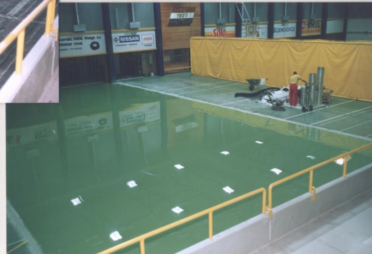
12. 8. 91 enda større areal av gulvet må rives. Det var fuktighet (vann) i svampegummilaget.
