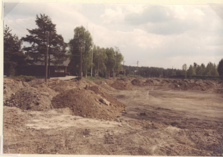
9.6.83 Kvabben fra halltomta ble kjørt til fotballbane og dermed løftes banen med ca. 1 m. for å siden drenere banen ordentlig.
