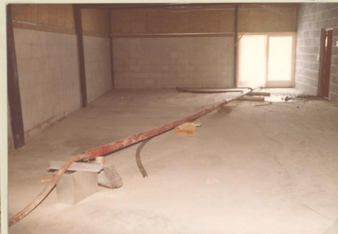
2.3.84 Det ble skåret huller i gulvet 2.3.84 for å få vannet bort og pumpe lenser vannet ut av døra.
