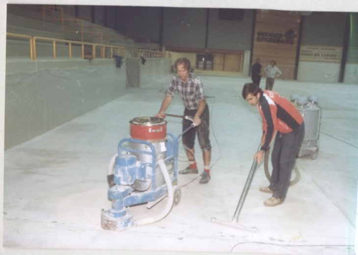
2.12.84 Hele gulvet må slipes på nytt. Arbeid som gikk hele døgnet rundt.
