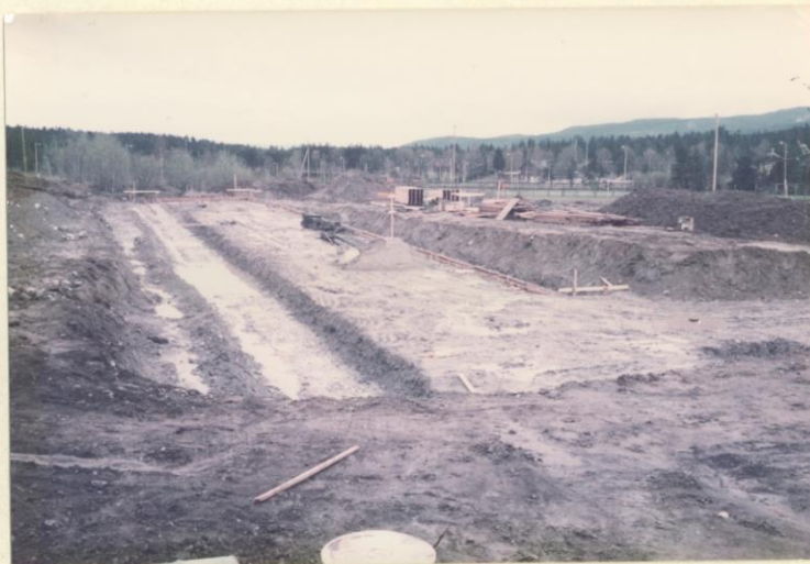
12.5.83 Regn og atter regn. Til tross av vannet går arbeidet videre. Forskaling av sålen er begynt.
