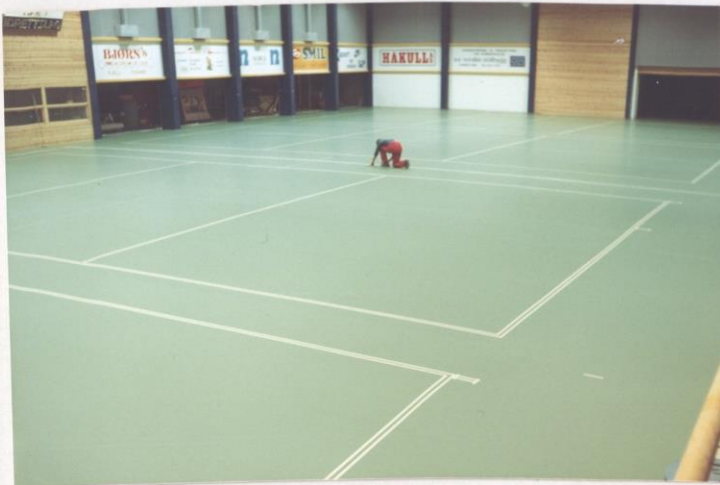
29. 1. 85 Det tapes for malingen av strekene
