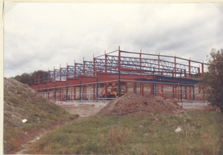
16.8.83 Alle takbjelker er på plass og en del takisolasjon ligger foran bygningen
