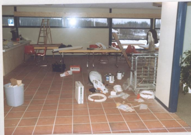
20.11.84 Bare elektrikere holder i Hallen
