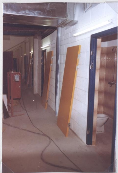
9.5.84 Arbeidet går tregt fram. Det slår fra uke til uke uten større forandringer.
