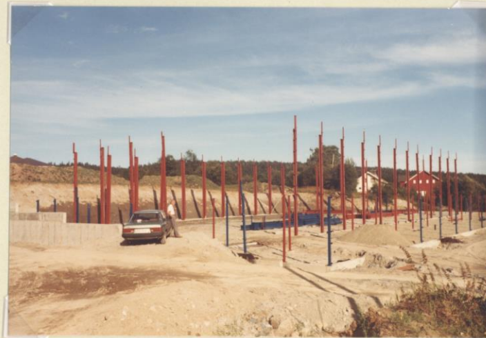
3.8.83 Söylene for takkonstruksjon er reist. Formannen Geirr er på plassen og tar en blick over framdriften.
