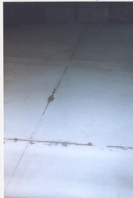
22.9.84 Det er vanskelig å få bort vannet
