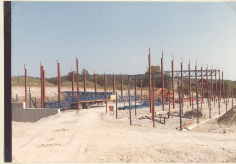
9.8.83 De første 2 takbjelker er satt på plass
