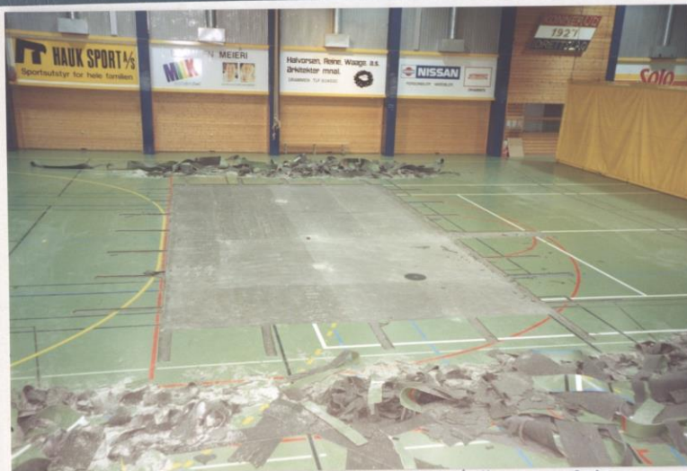
12. 7. 91 begynte å rive gulvet for å tette vannlekasje.
