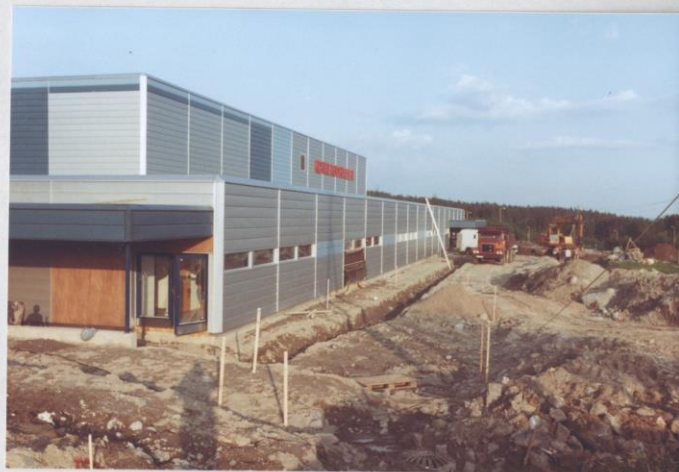
30.5.84 Det graves kabler ned og planeringen foran inngangen har begynt.
